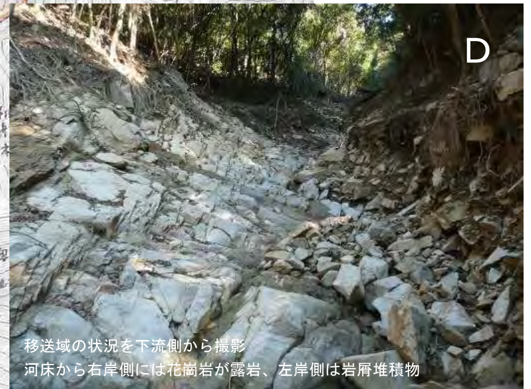
C 人工平坦面直下の表層崩壊、マサからなり流水跡が多くみられる
