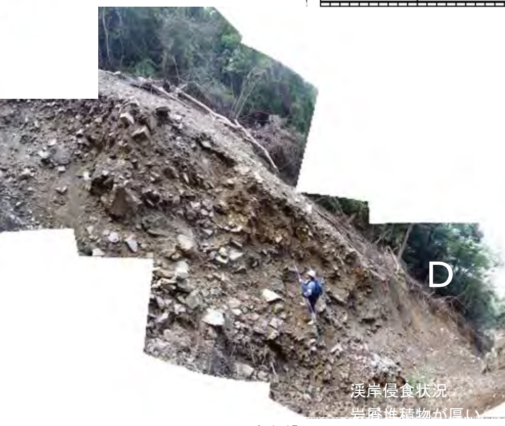
移送域の状況を下流側から撮影 河床から右岸側には花崗岩が露岩、左岸側は岩屑堆積物
