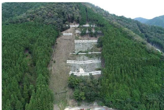
神納川区域：⑤-2山腹工 五百瀬1 山腹工
