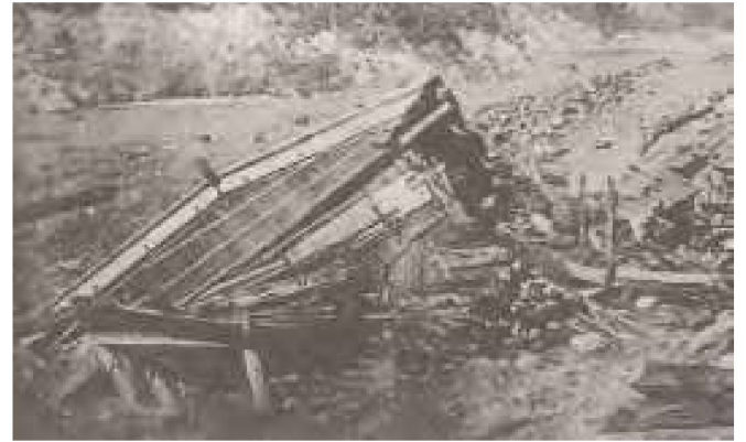
家屋の被災状況
