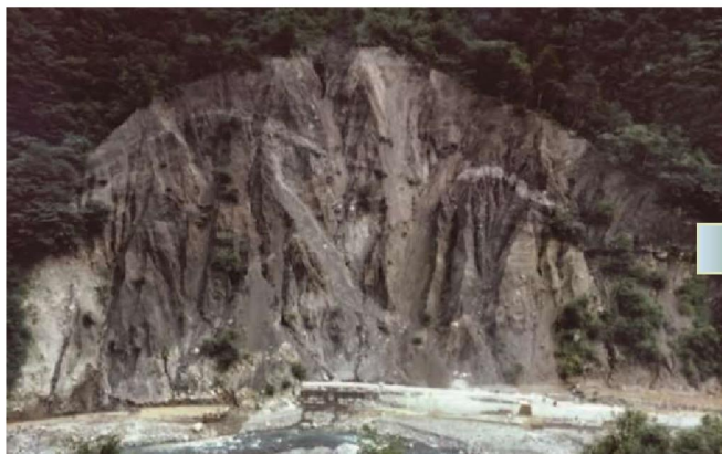
施工前の荒廃状況（昭和46年撮影）
