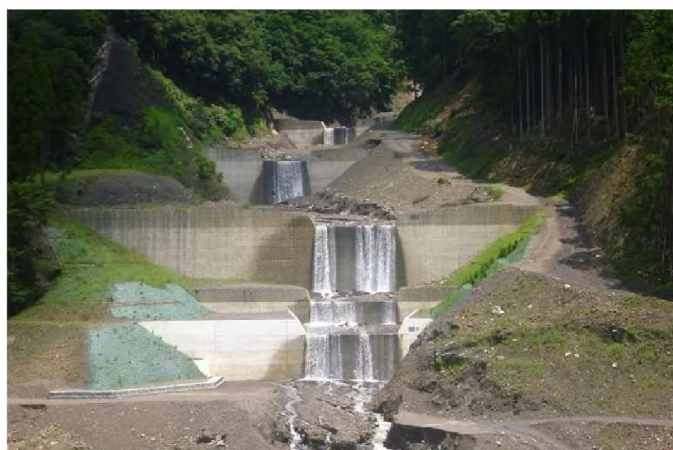
野尻区域：⑥-1 野尻（下部） 谷止工 5基
