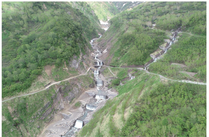
溪間工の施工（本流第23号～32号）
