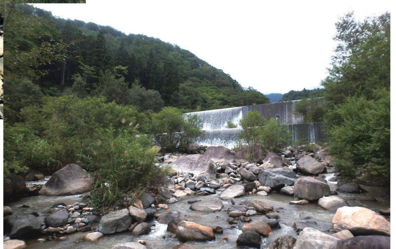
施工後の状況(令和元年)
