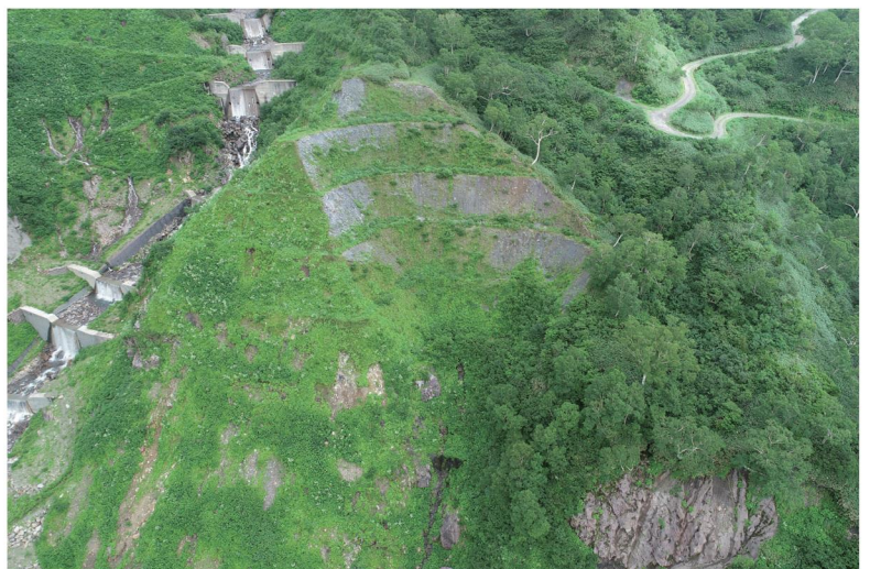
山腹工の施工（ホ-13-2崩壊地）
