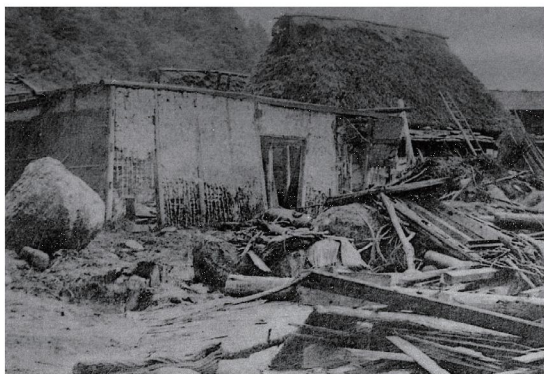
家屋の被害状況
