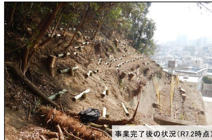
木杭打工の説明
