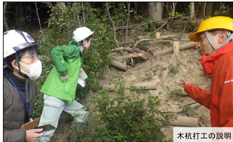
木杭打工の説明
