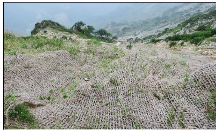
ヤシ繊維ネット伏工(米原市施工)
