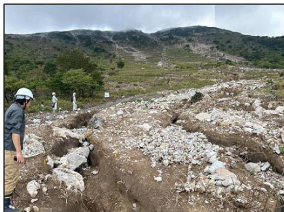
伊吹山被災状況(R6.9時点)
