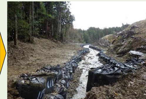
▲【珠洲市 南方：倒木撤去、大型土のう設置 施工状況】
