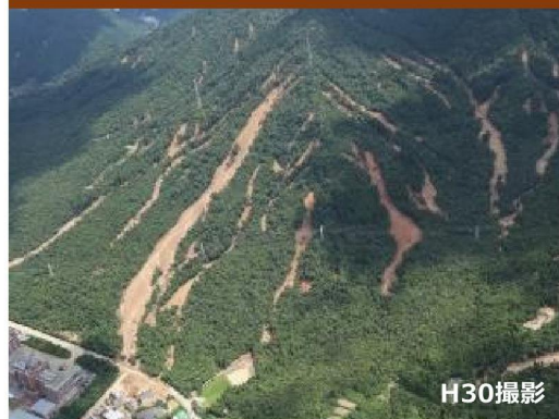
▲【大規模崩壊地】 (黒瀬区域)
