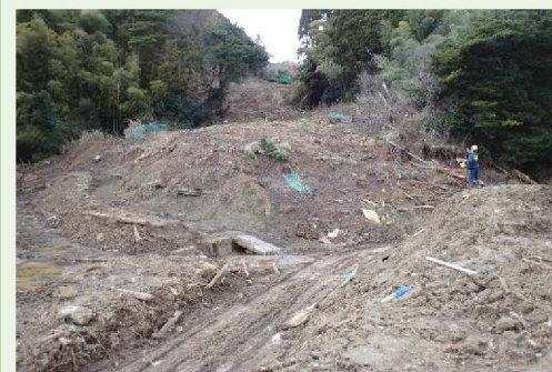
▲【珠洲市 大谷町：土砂撤去、大型円筒金網設置 施工状況】
