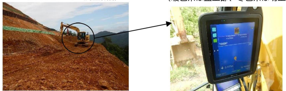
▲ICT建機による掘削作業状況
