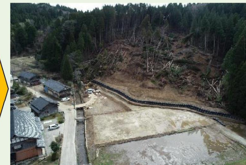
▲【輪島市 興徳寺：倒木撤去、土砂撤去、大型土のう設置 施工状況】
