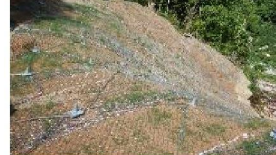
ボーリング暗きょ工 (H30完成)
