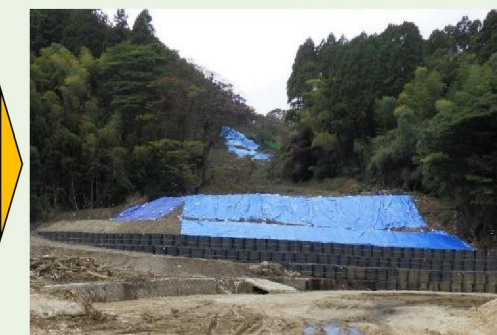
▲【珠洲市 大谷町：土砂撤去、大型円筒金網設置 施工状況】
