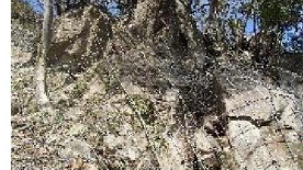
斜面補強ネット工 (R4完成)
