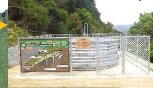
4号集水井工(R3完成)
