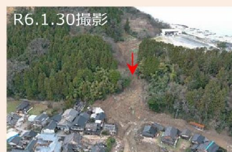
【珠洲市大谷：民家に被害】
