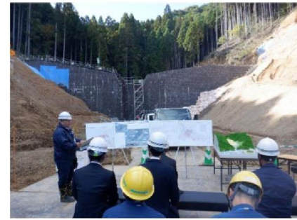
▲国土交通省（砂防）・地元自治体との技術交流会（京都大阪森林管理事務所管内）
