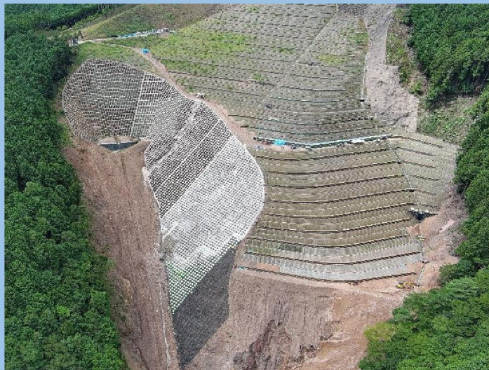
(上平治川区域：山腹工施工中)
