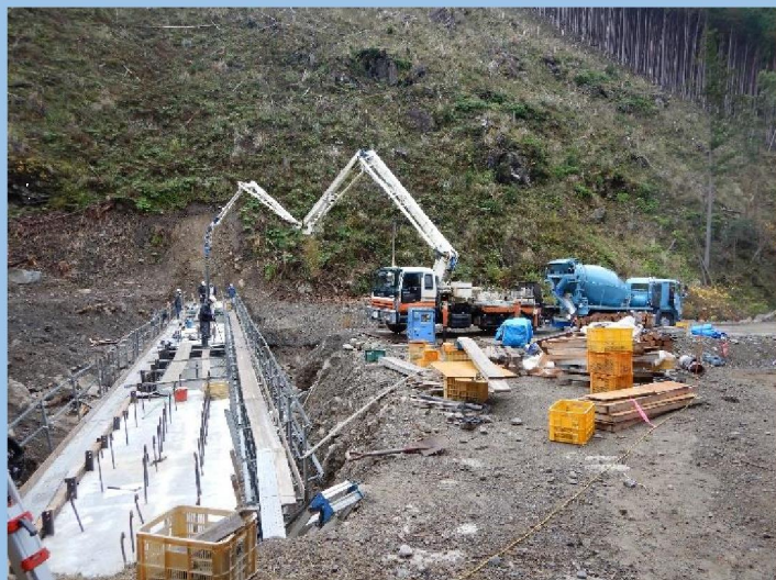
(本田垣内区域：治山ダム工施工中)
