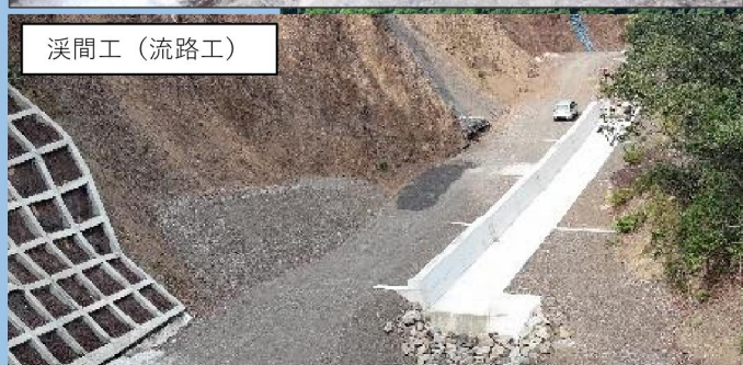
山腹工（法枠工）
