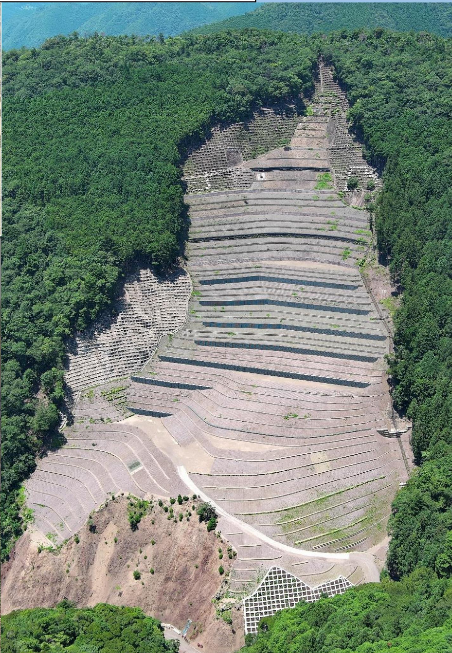
山腹工（法枠工）
