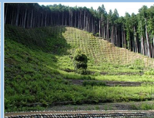
施工から3年後 (H29.8)
