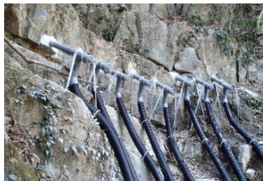
施工事例（上秋津：H30施工）
