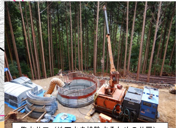
集水井工（地下水を排除するための井戸）
