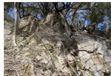
施工事例（上秋津：H30施工）
