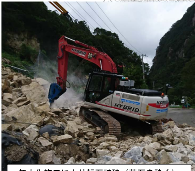
無人化施工により転石破碎（落石を砕く）
