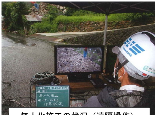
無人化施工の状況（遠隔操作）
