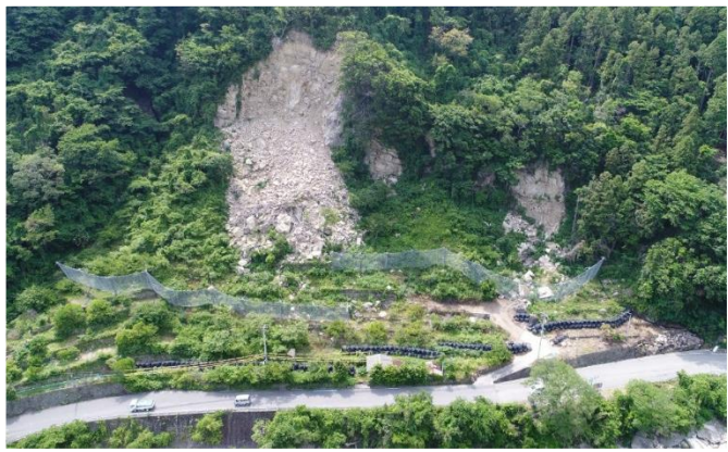
崩壊前(令和元年6月6日撮影)
