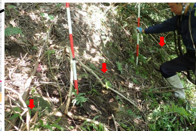
今回の崩壊箇所の後背斜面で見つかった段差亀裂 3
