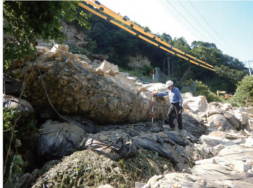
⑤破損したタンポバリアー：倒伏したものの減勢効果は発揮したものと推定。
