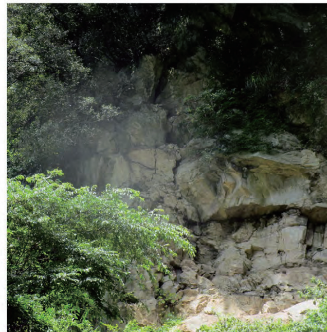
開口亀裂箇所の拡大
