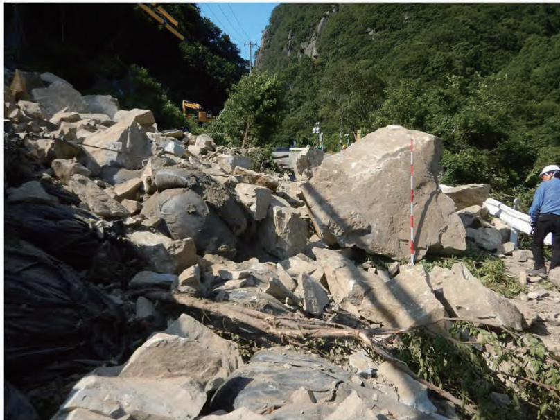
⑥県道に到達した巨石：大きなもので2.0m×1.6m×1.6m程度。
