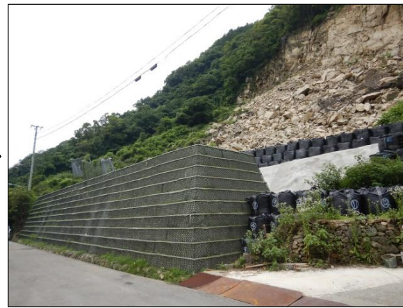
令和2年5月 擁壁（高さ5m）完成
