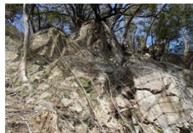
施工事例（上秋津：H30施工）
