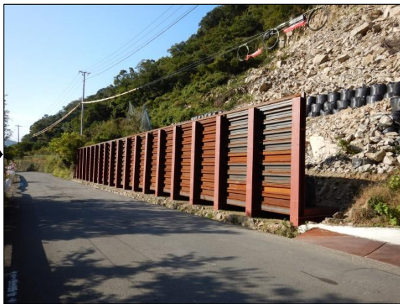
令和元年11月 防護柵（仮設）の設置
