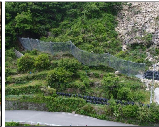
令和2年5月 落石防護柵の補修完了
