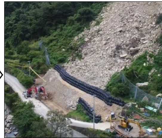
令和元年10月 土砂撤去と大型土のう設置
