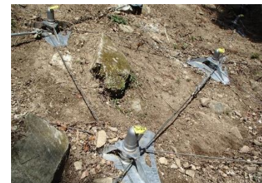
施工事例（上秋津：H30施工）
