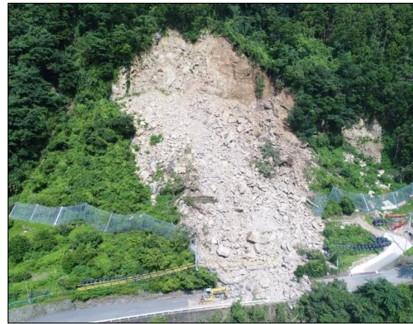
令和元年7月28日 斜面の拡大崩壊（落石防護柵が破損）
