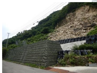
補強土擁壁（幅36m、高さ5m） R2. 5. 28完成
