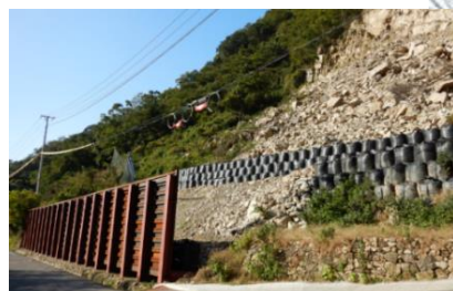
仮設防護柵（幅36m、高さ4m） R1. 11. 13完成
