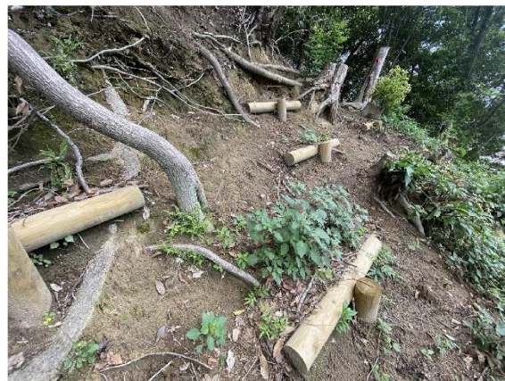
写真-4 施工後 4 か月
