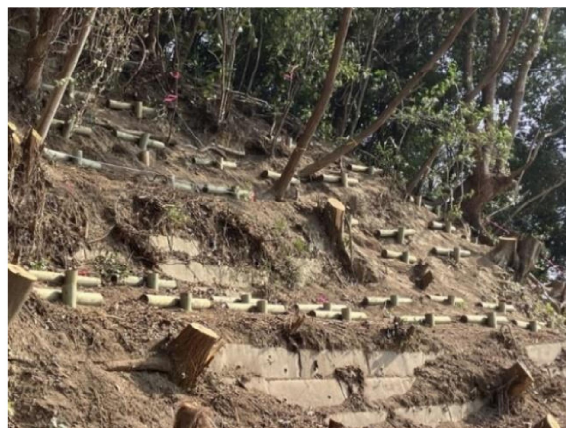
写真-3 施工直後の斜面状況
