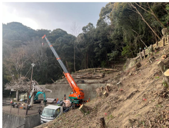
写真-2 危険木伐採後の斜面
