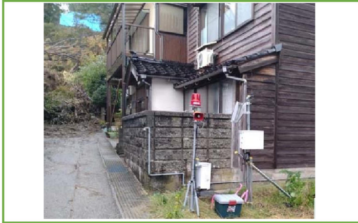
警報装置設置状況
