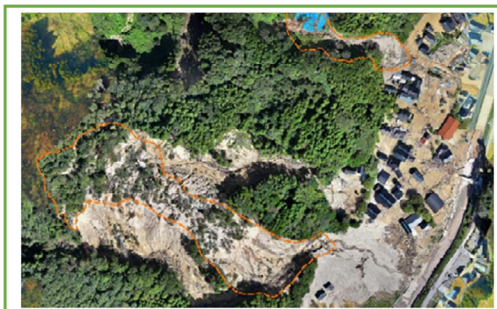
オルソ写真の作成（土砂流出状況確認）
