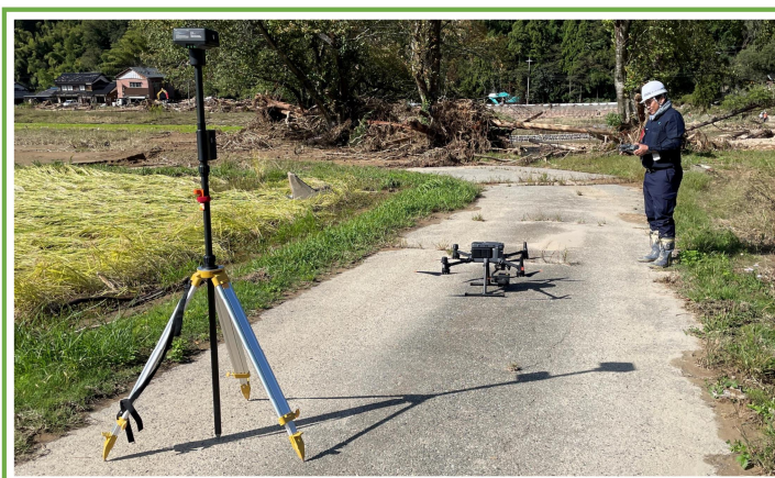
UAVレーザ測量状況
