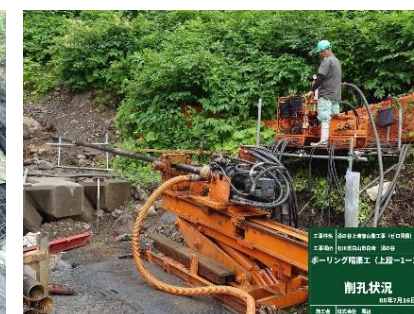
ボーリング暗渠工 施工状況
