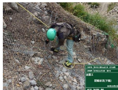
法面工 施工状況
