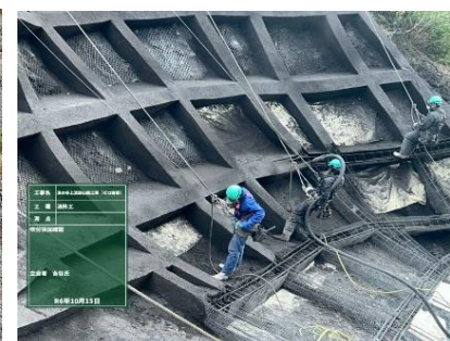
法枠工 吹付状況 (周辺景観・環境配慮)
