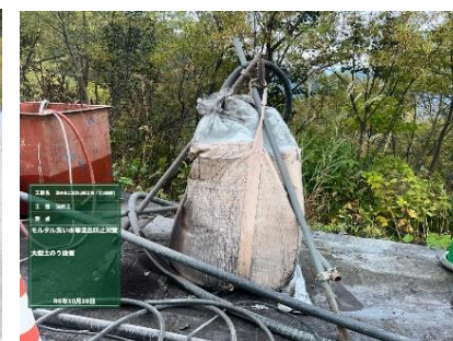
汚水等の流出防止 (大型土のう内で洗浄、産業廃棄物として処理)
