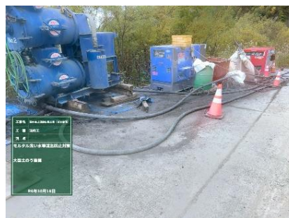
汚水等の流出防止 (大型土のう内で洗浄、産業廃棄物として処理)
