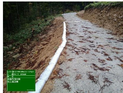
法面の浸食防止のため、枕土のうを設置
