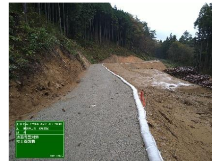
法面の浸食防止のため、枕土のうを設置
