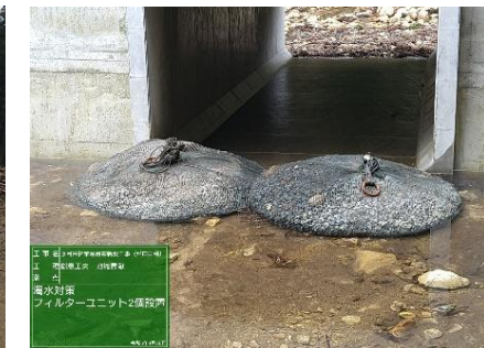
大型フィルターユニットによる濁水対策
