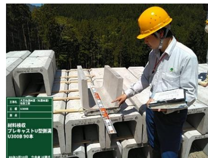
コンクリート二次製品を使用した施工日数の縮減（コスト縮減）
