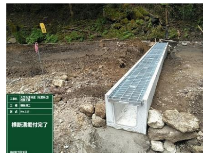
コンクリート二次製品を使用した施工日数の縮減（コスト縮減）
