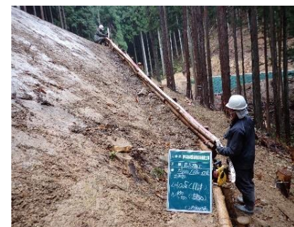
木柵工の材料に現地採取木材を採用（環境配慮）
