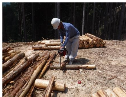
木柵工の材料に現地採取木材を採用（環境配慮）
