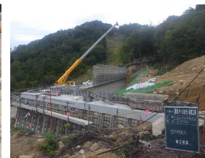
スライド式型枠の採用（品質管理）
