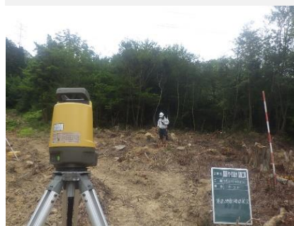
3次元起工測量
