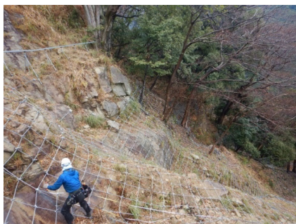
ロープ伏工 (令和3年1月完成)
