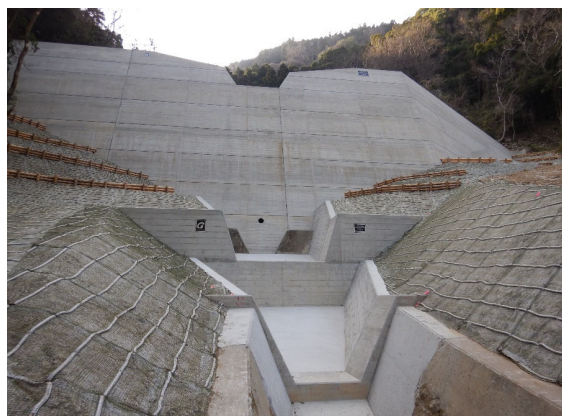
治山ダム (L=60m、H=14m) (令和3年3月完成)
