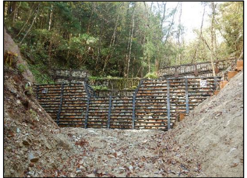
完成した治山施設（鋼製棒谷止） かばたにやま 栴谷山国有林（吉賀町）
