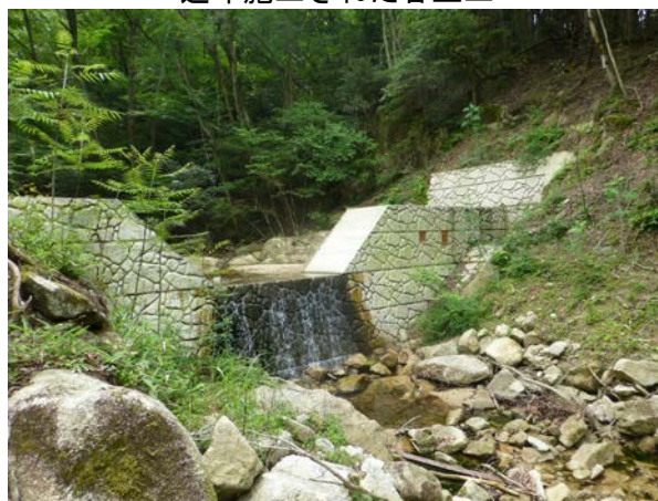
近年施工された谷止工
