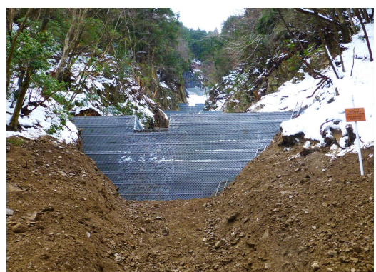
大河原国有林(甲賀市)山腹工
