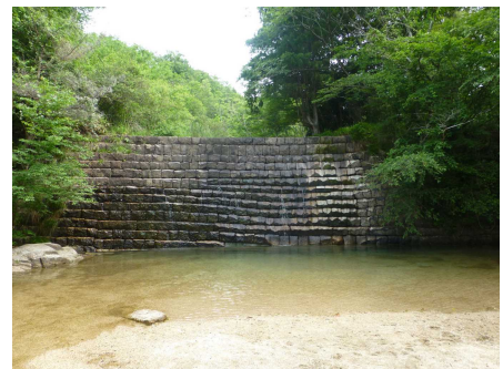
オランダ堰堤(明治期に施工)
