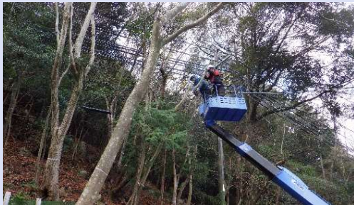
民家横（作業中）
