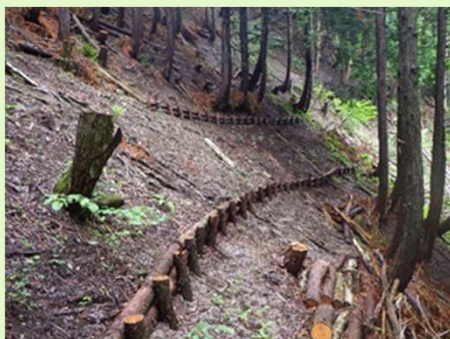
保安林整備：本数調整伐・筋工
