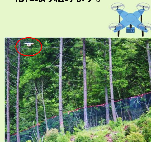
ドローンによる防護柵点検(自動飛行)
