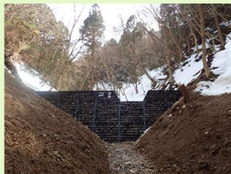
治山事業：溪間工(治山ダム)
