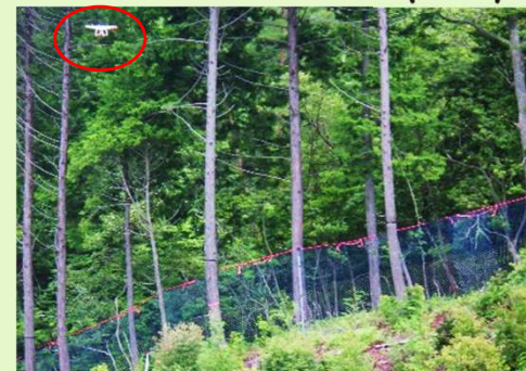
ドローンによる防護柵点検(自動飛行)
