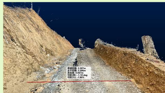
3次元点群データを活用した出来形管理
