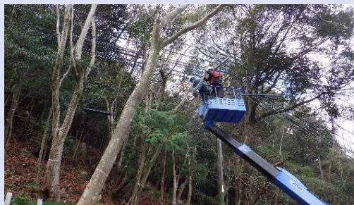
民家横（作業中）
