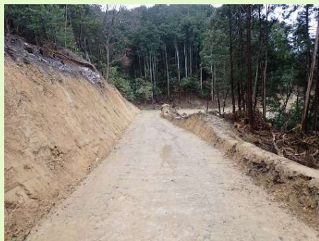
奥島山国有林：林業専用道新設
