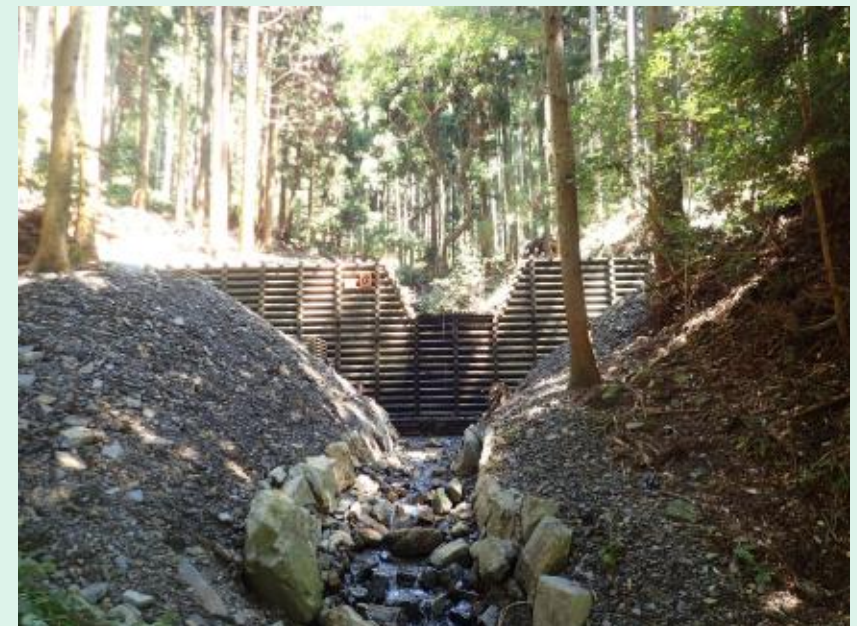
施工後（溪間工）
