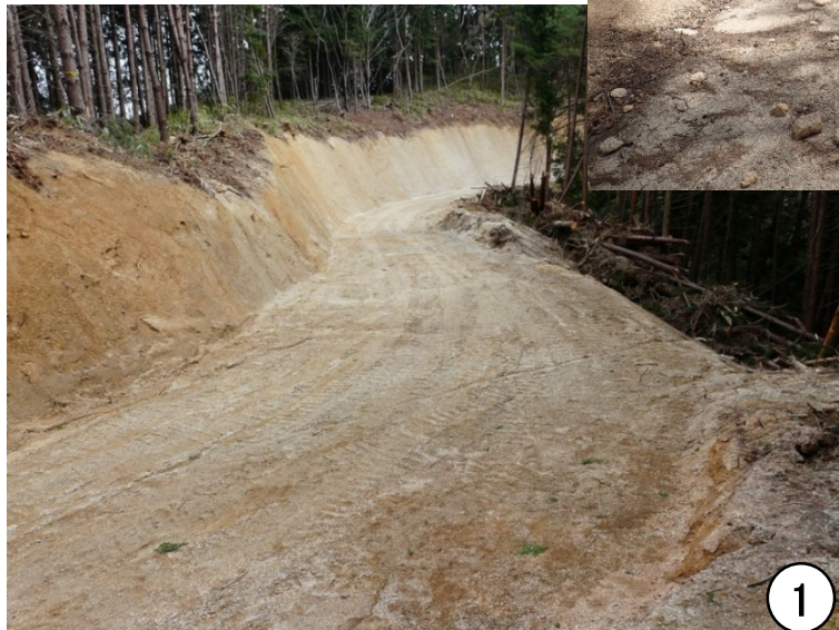
平成26年度新設箇所の状況 (法面保護工及び路盤工なし)
