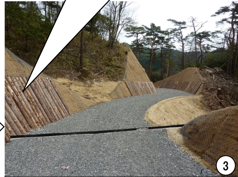
平成27年度新設箇所の状況 (法面保護工及び路盤工あり)
