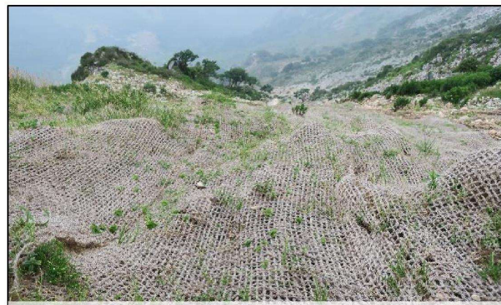
ヤシ繊維ネット伏工（米原市施工）
