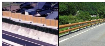
遮音壁、木製ガードレール 等
