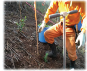
植穴とコンテナ苗が密着する程度に踏固め、乾燥防止策として苗木根元に落葉等を寄せる
