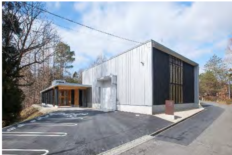
林業技術研修棟
