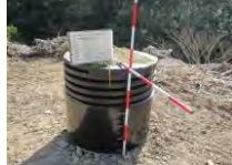
大型排水管を利用した残渣処理
