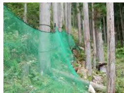
【安価なネットによるシカ柵の設置】 みやしろがわ (和歌山県すさみ町 宮城川国有林)
