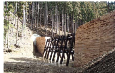
間伐材を使用した型枠
