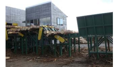
【システム販売先合板工場の様子】
