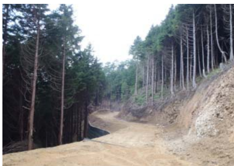
団地内林業専用道(国有林内)
