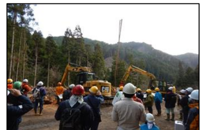
架線による木材搬出の様子
