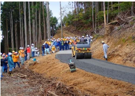
森林整備センターによる路盤改良の実演
