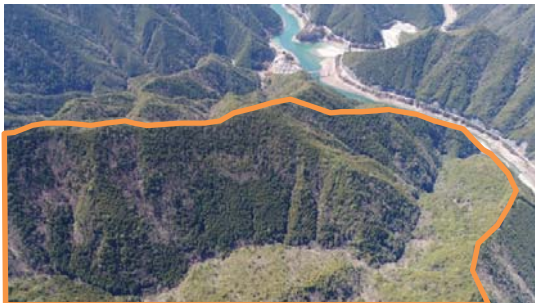
黒瀬谷国有林(枠内)とその周辺の様子
