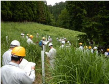
防護柵の維持管理の説明 （マンガ谷国有林）
