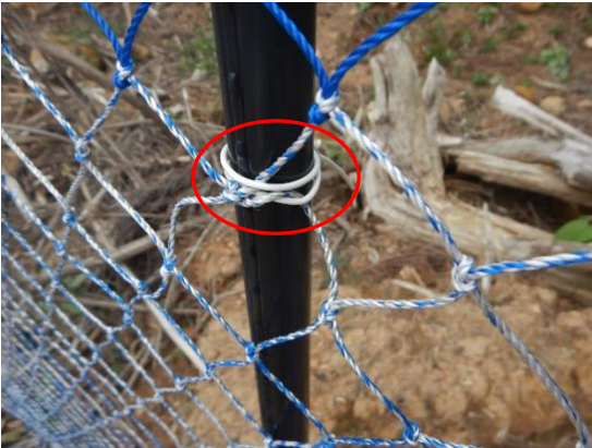
森林整備センターの仕様 (被覆番線による支柱と網の結合)
