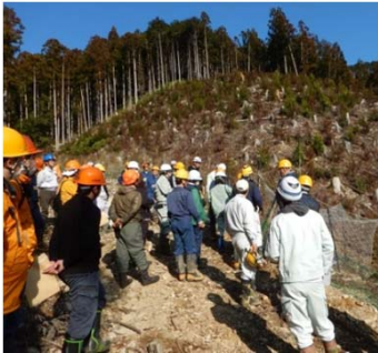
斜め張り防護柵の設置状況を説明
