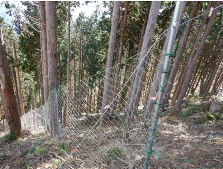
上張りロープにワイヤーロープを設置
