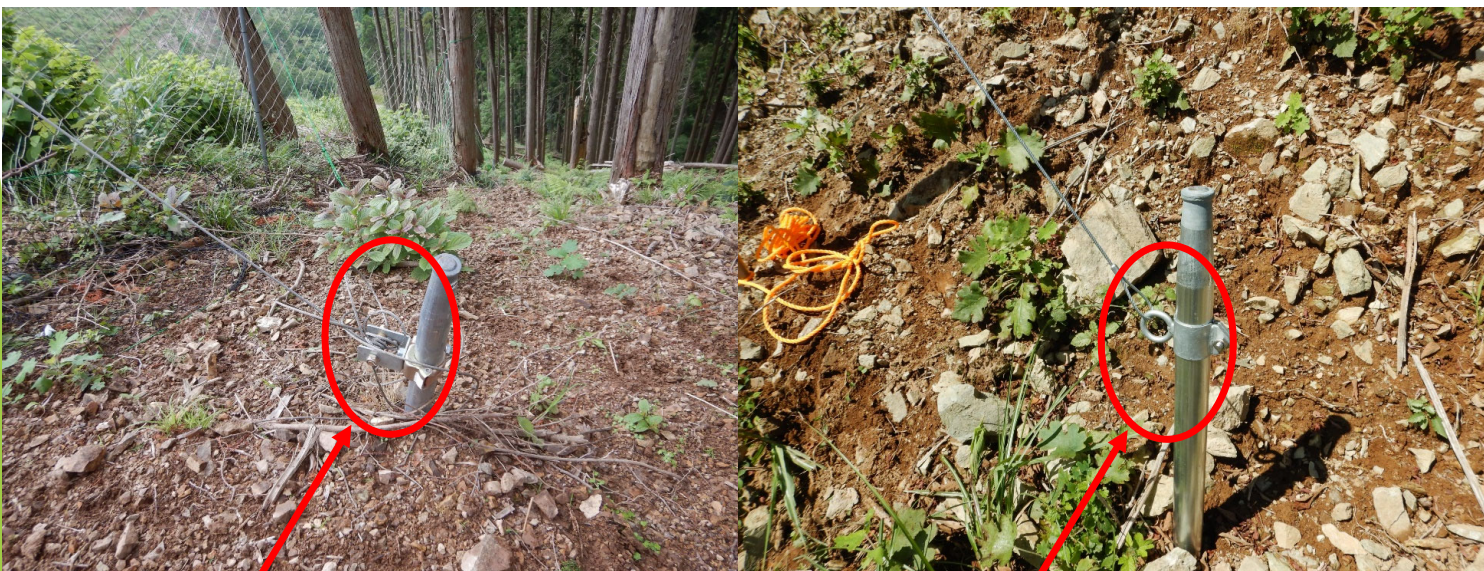
防護柵の終点側に設置する ワイヤーロープ控え用杭
