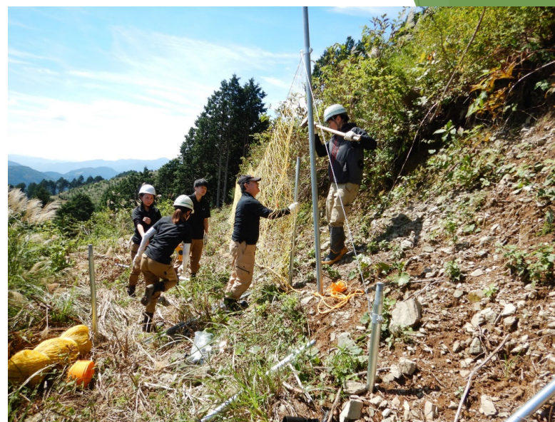
鋼管支柱 設置の様子
