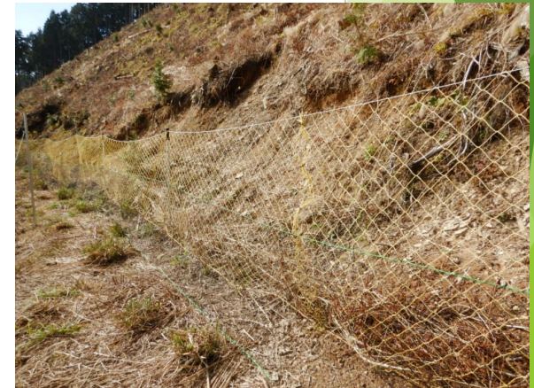
上張りワイヤーロープを 用いた防護柵
