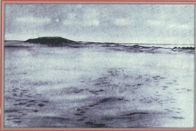
復旧前の状況(明治43年6月撮影)
