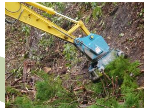
グラップルにより 林地を整理
