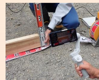
材料検収状況 (型枠資材)
