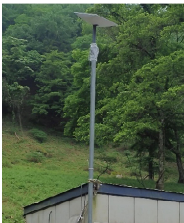
現場事務所へのアンテナ設置状況
