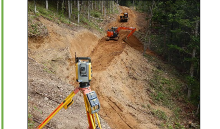
自動追尾型TSによるマシンガイダンス
