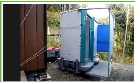
快適トイレ設置状況の遠隔確認
