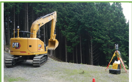
使用したICT建設機械(同機種)と自動追尾型トータルステーション
