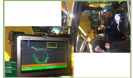
マシンコントロールガイダンスによる重機操作
