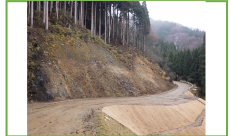
掘削・盛土法面出来栄
