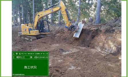
MC機械掘削(チルトローテーター使用)
