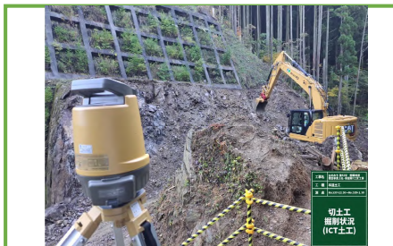
MGバックホウによる切土工
