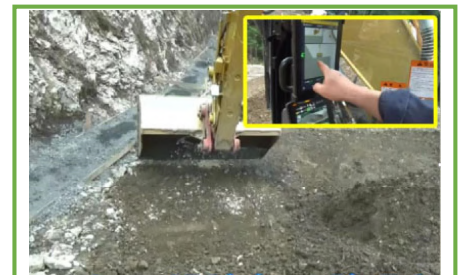
モニターで設計高さを確認しながら掘削作業中
