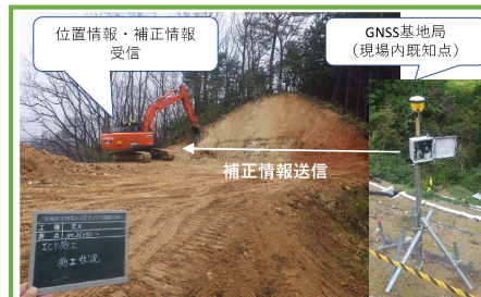
人工衛星から位置情報を、基地局から補正情報を受信し、高精度な位置情報を得て掘削
