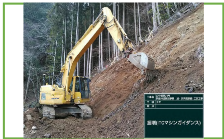
MGバックホウによる掘削作業
