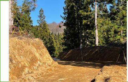
TLSによる出来形計測状況
