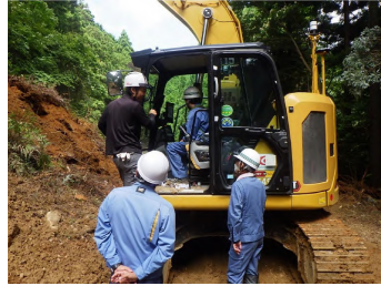
掘削状況確認 マシンコントロール確認
