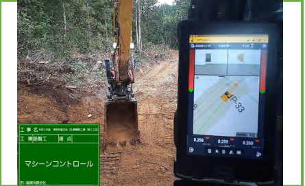
MC機械掘削時、運転席モニター
