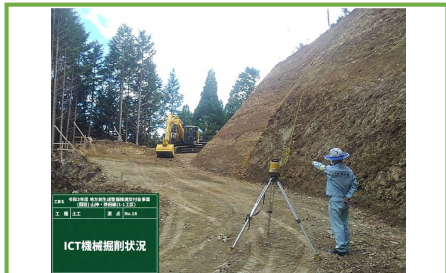
3DMGA ® ツクワによる掘削状況
