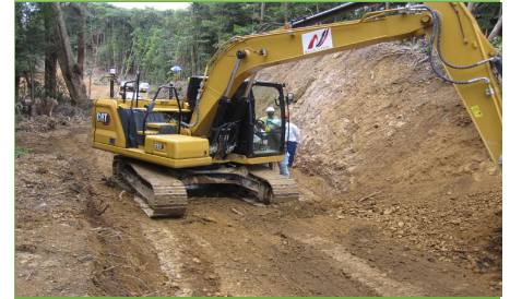
ICT建機による法面掘削
