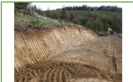
MGバックホウにより整形した法面
