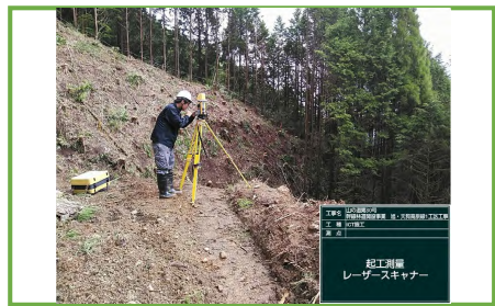
TLSによる起工測量
