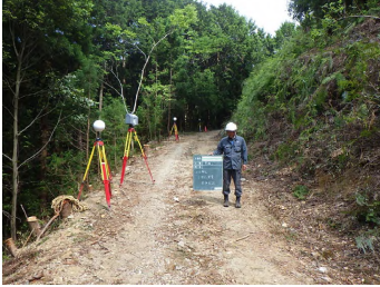
3次元測量実施状況
