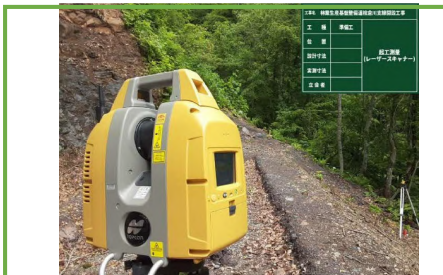
TLSによる起工測量
