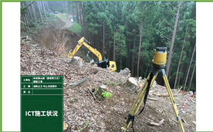
地上型レーザースキャナーにより掘削法面とバックホウのショベル先端の位置関係を管理
