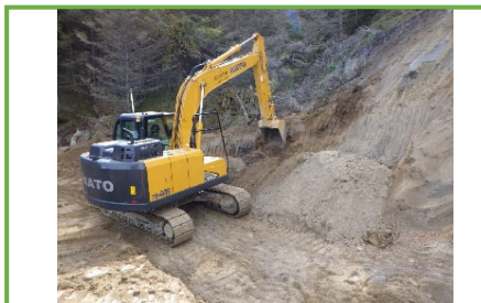
MGバックホウによる掘削（法面整形）
