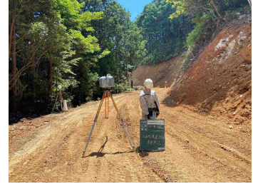
出来形測量 (TLS) 状況
