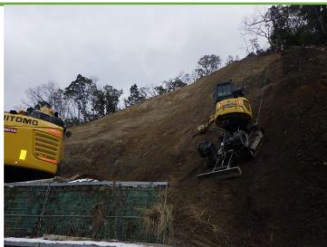
掘削状況（右側がMGバックホウ）
