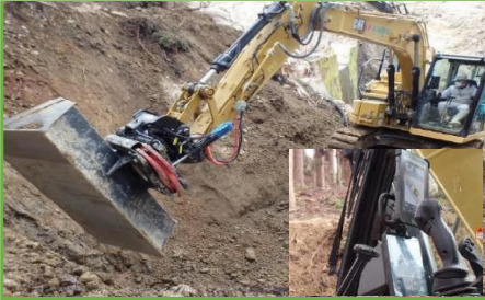
ICT建機施工(床掘)
