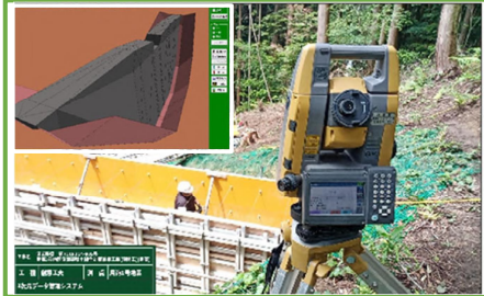
型枠組立時の測量作業(左上:3Dビュー)
