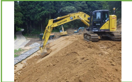
ICT建設機械による盛土法面整形
