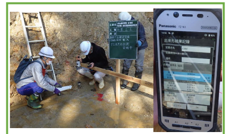
TS出来形計測 実施状況
