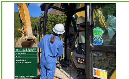
掘削状況確認 マシンコントロール確認
