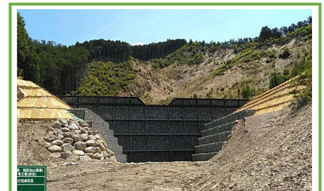
完成写真（正面）
