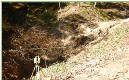
地上型レーザー scanner による起工測量
