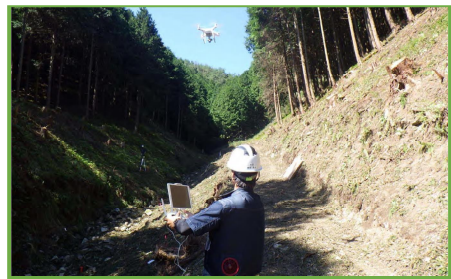
UAVによる起工測量状況
