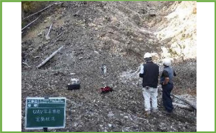
UAV写真測量 フライト実施状況
