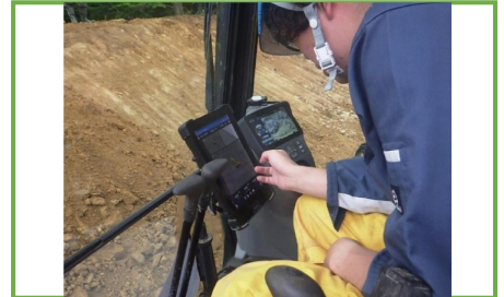
モニターでバケット位置をリアルタイムに確認
