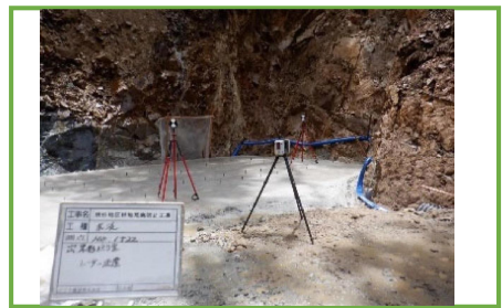
レーザースキャンによる出来形管理
