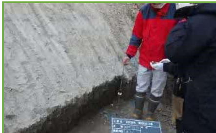
TSによる床掘面の出来型測定状況
