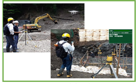
UAVによる出来形計測
