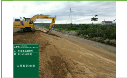
3D-MCバックホウによる法面整形
