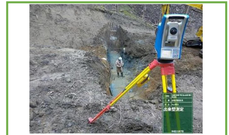
トータルステーション等による床掘の基準高の測定（出来形管理）
