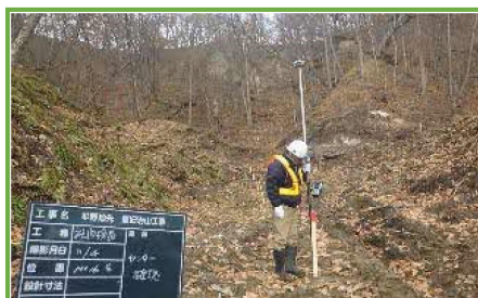
RTK-GNSSによる起工測量
