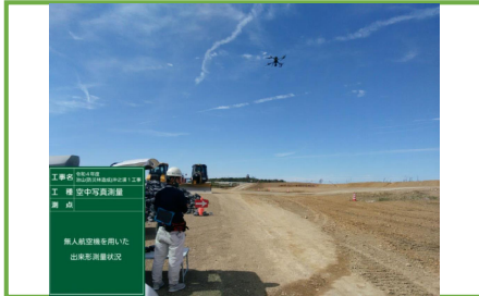
空中写真による出来形計測
