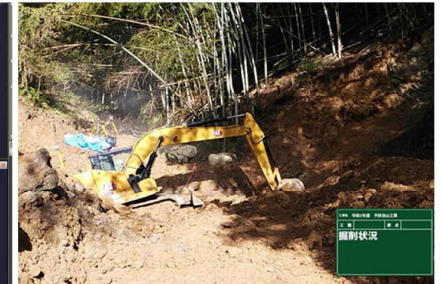
MGバックホウによる掘削
