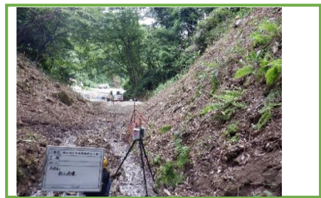
レーザースキャンによる起工測量
