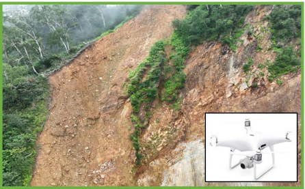
ドローン写真測量箇所及び測量に使用したドローン
