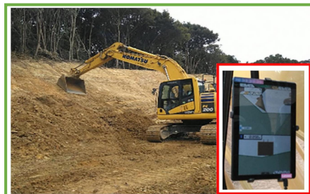
MGNツツホウによる法面整形（右下：モニター）
