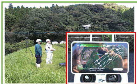
UAVによる三次元起工測量
