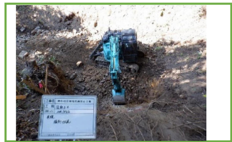
MGバックホウによる掘削
