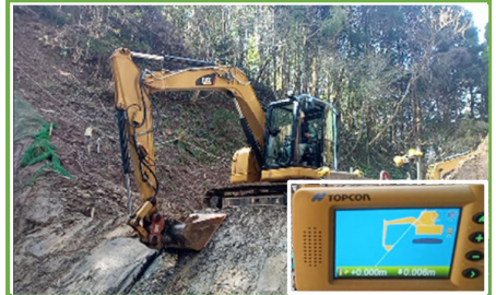
2Dシヨベルガイダンスを使用した法面整形作業
