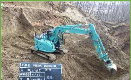
バックホウ (マシイダダ) による床掘
