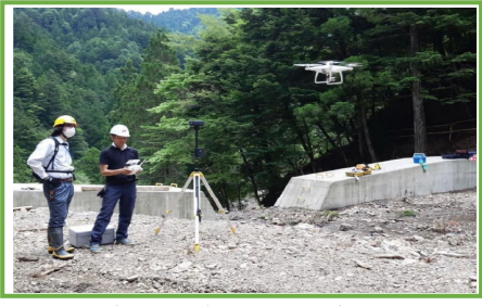
UAV（ドローン）を活用した起工測量
