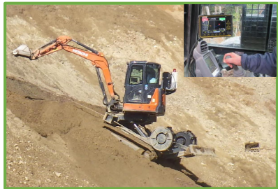
ICT重機による作業状況 （MG付き高所法面掘削機械）
