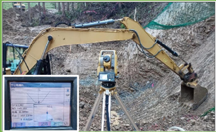
3次元設計データを用いた掘削時の測量
