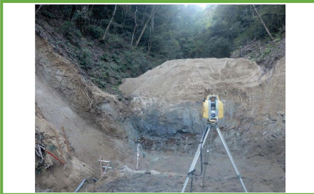
TS光波方式による3次元出来形計測
