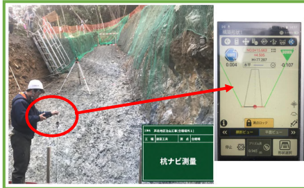
床堀の3次元データを活用し、測定位置の幅、高さなどをリアルタイムで確認
