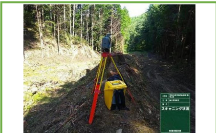
レーザースキャナーによる起工測量
