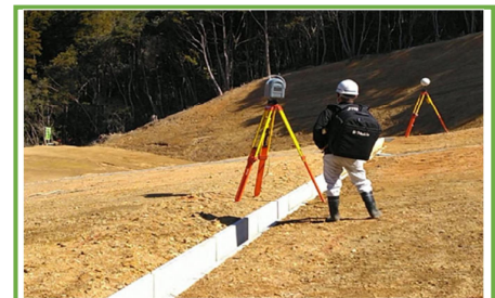
TLSによる出来形管理
