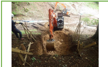
MGバックホウによる掘削
