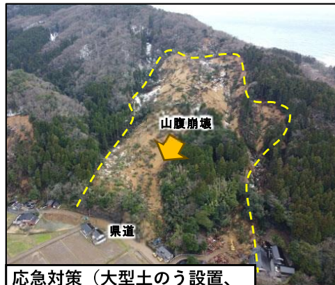
【被災状況】 珠洲市大谷の山腹崩壊
