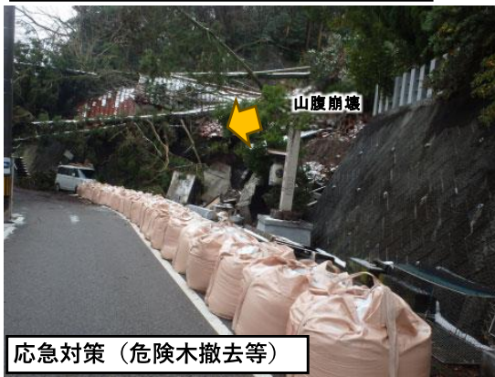
【被災状況】 輪島市鳳至の山腹崩壊
