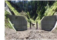
流木捕捉式治山ダム
