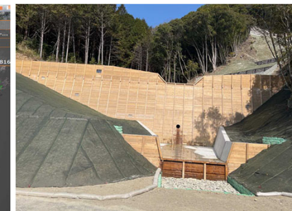
残置式木製型枠による木材利用を推進
