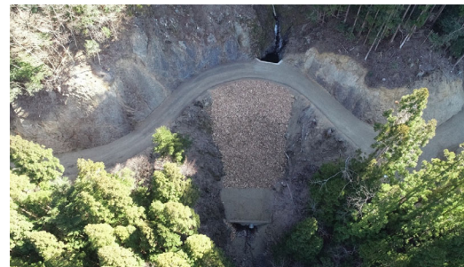
完成写真（現地発生支障木等をチップ化し盛土法面に散布し流出防止を図った。）
