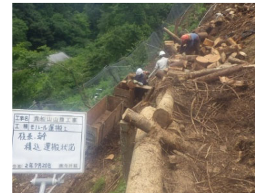
風倒木処理を安全に配慮し、モノレールやヘリコプターで搬出
