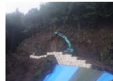
ロングアームのバックホウによる作業
