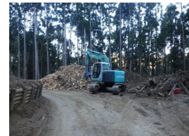
現地発生支障木の枝条の細断
