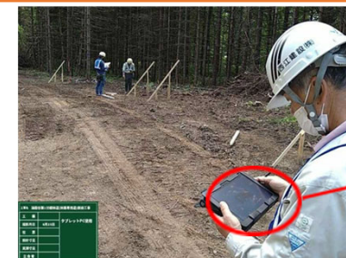
現地での出来形確認の際にタブレットPCでCADを活用し、画面上で設計図上の距離や面積の確認を行い、設計変更にも素早く対応
