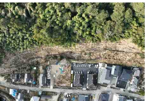
ドローンによる治山事業地調査
