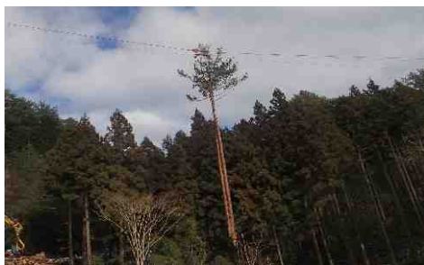
架線集材作業
