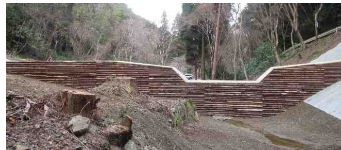
谷止工（残存型枠）（令和6年度完成）
