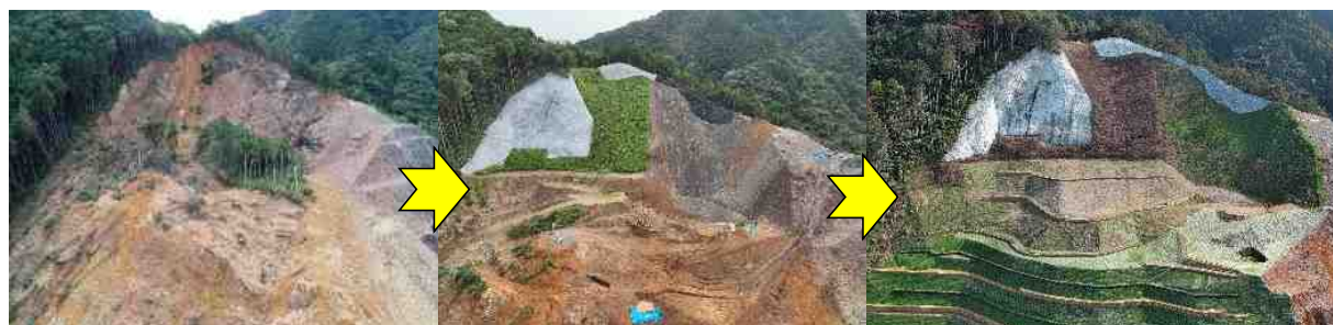
山腹被害状況（古屋国有林） 山腹工（令和4年度実行箇所） 山腹工（令和5年度実行箇所）
